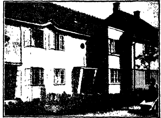
वीयनाका उपवन भवन नं० २१
